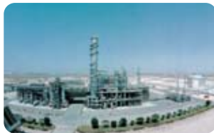
メタノールプラント
